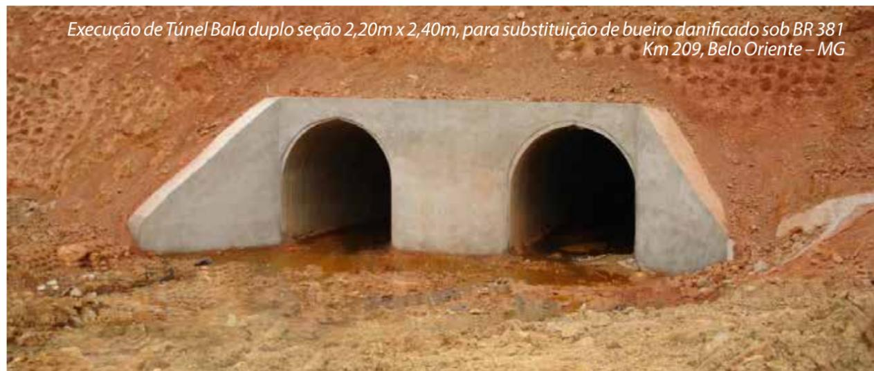
Execução de Túnel Bala duplo seção 2,20m x 2,40m, para substituição de bueiro danificado sob BR 381 Km 209, Belo Oriente – MG
