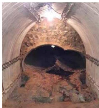
Substituição de bueiro metálico
