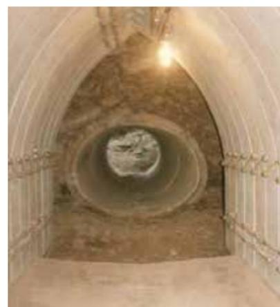
Substituição de bueiro concreto
