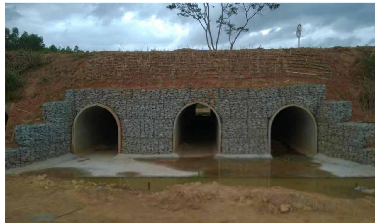
*A metodologia Túnel Bala é normatizada pelo DNIT NORMA 096/2006 - ES (Drenagem - Bueiros de concreto tipo minitúnel sem interrupção do tráfego)*
