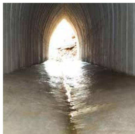
Túnel Bala seção de 0,80m x 1,40m como duto direto de esgoto sanitário
