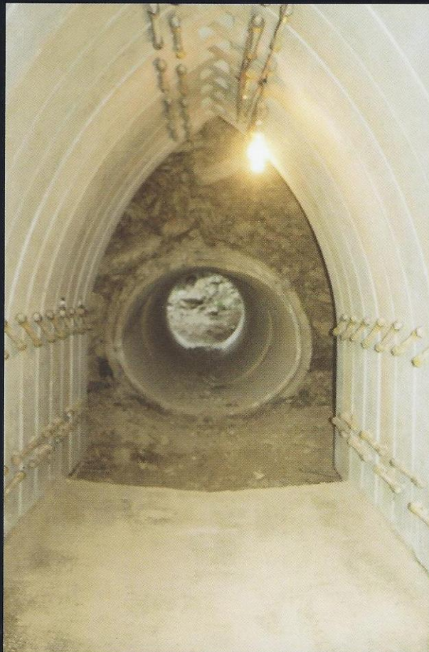
Substituição de BSTC danificado sob MG 202 em Arinos - MG Cliente: DER (MG)
